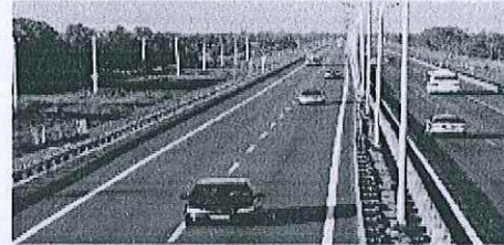
Hình ảnh 2: Cao tốc Tp. Hồ Chí Minh - Trung Lương. Thi công các đường và cầu trên tuyến (2005-2008)
